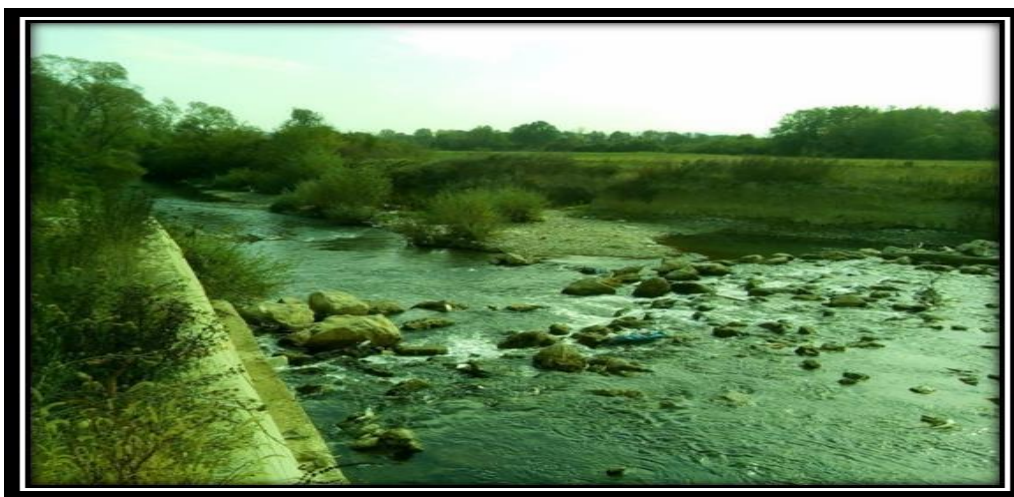
Slika 17: Inertni depoziti – naselje Veiko Krushevo Grande - prikaz ispod brane
