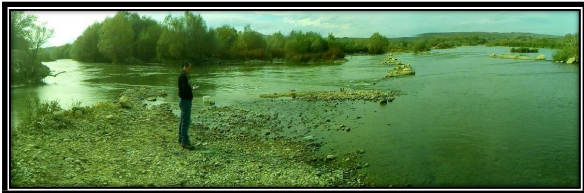
Slika 36: Segment ispod Rakovinskog mosta
