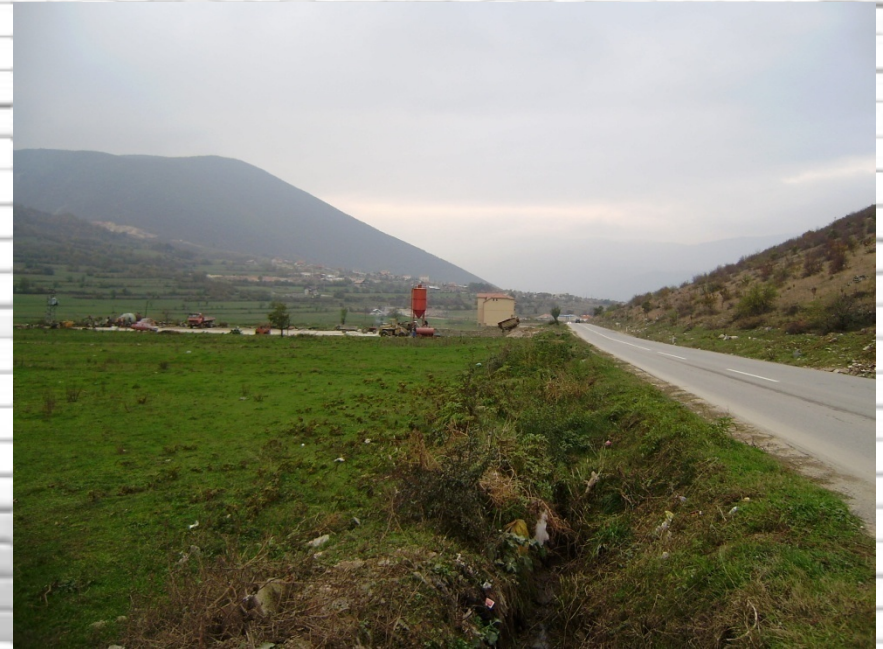
Lokacioni i sistemit të shkarkimit të HC Zhur I – Sistemit Bartës të HC Zhur II
