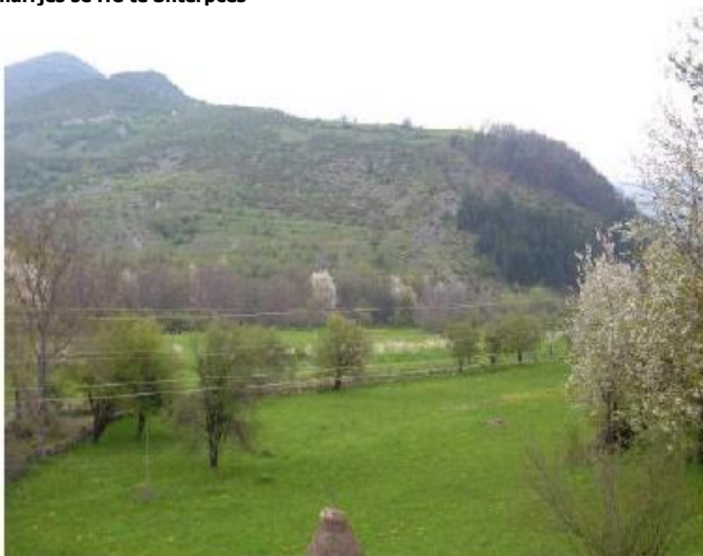
Figura 102.: Lumi i Lepencit. Shpate të paqëndrueshme në perëndim të ndërtesës së centralit të Shtërpcës
