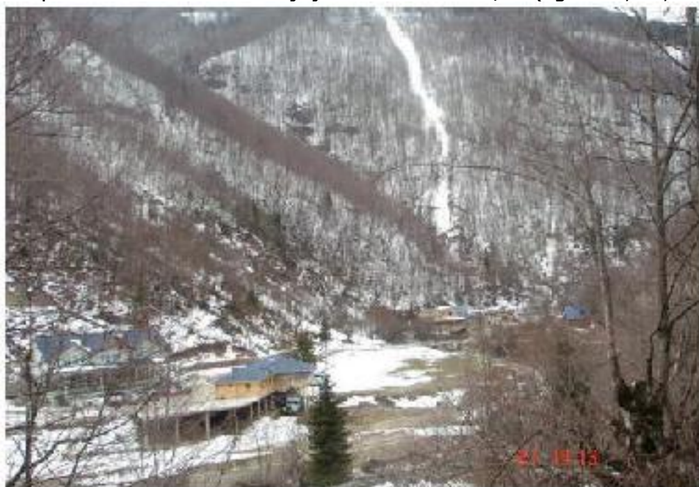
Figura 9.: Lumëbardhi i Pejës. Zona ku do të kalojë kanali i HEC-it të Shtupeçit
